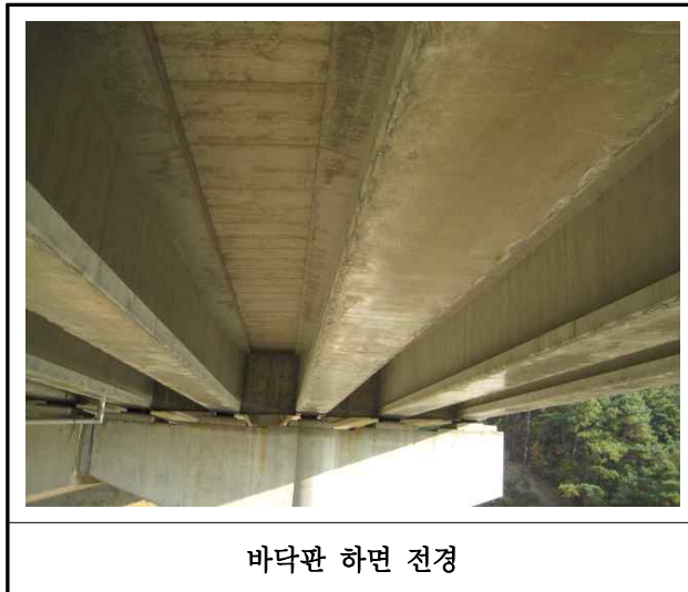
【사진 12.3.25】 바닥판하면 전경
