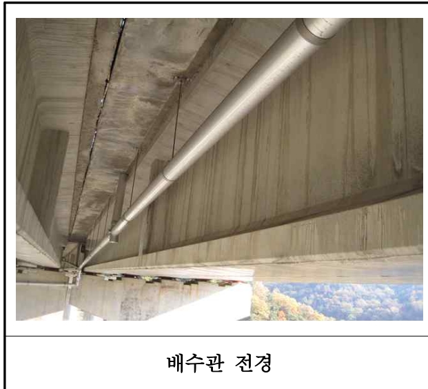
【사진 12.3.44】 배수시설 전경
