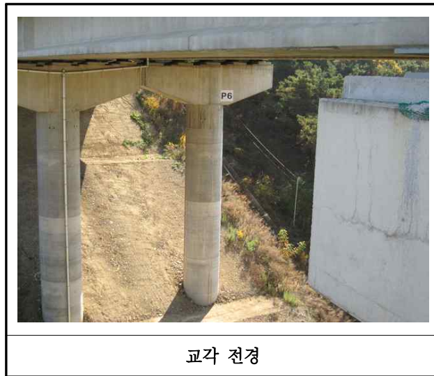
【사진 12.3.33】 교각 전경
