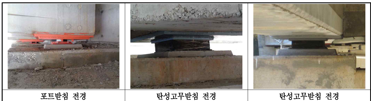
【사진 12.3.12】 교량반침 전경
