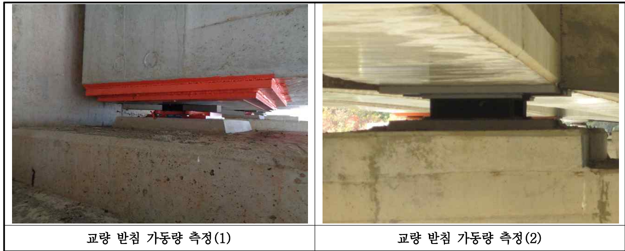
【사진 12.3.38】 교량받침 이동량 측정
