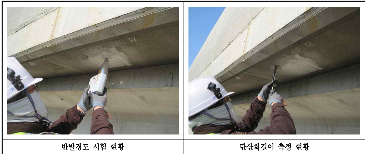
【사진 12.4.1】 콘크리트 내구성조사 현황
