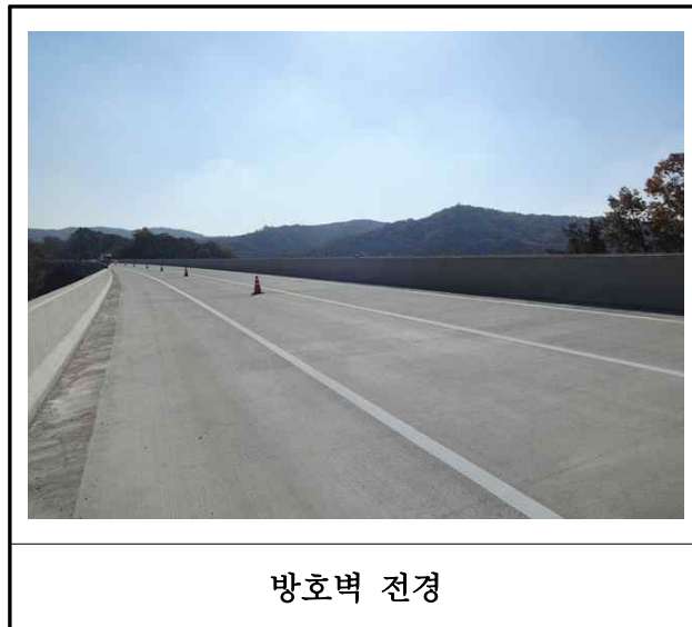
【사진 12.3.23】 방호벽 및 중앙분리대 전경
