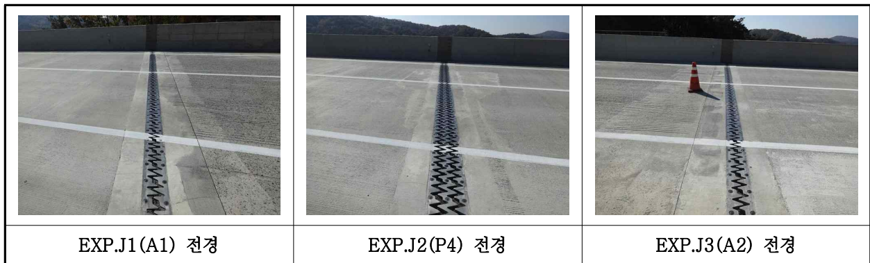
【사진 12.3.16】 신축이음장치 전경
