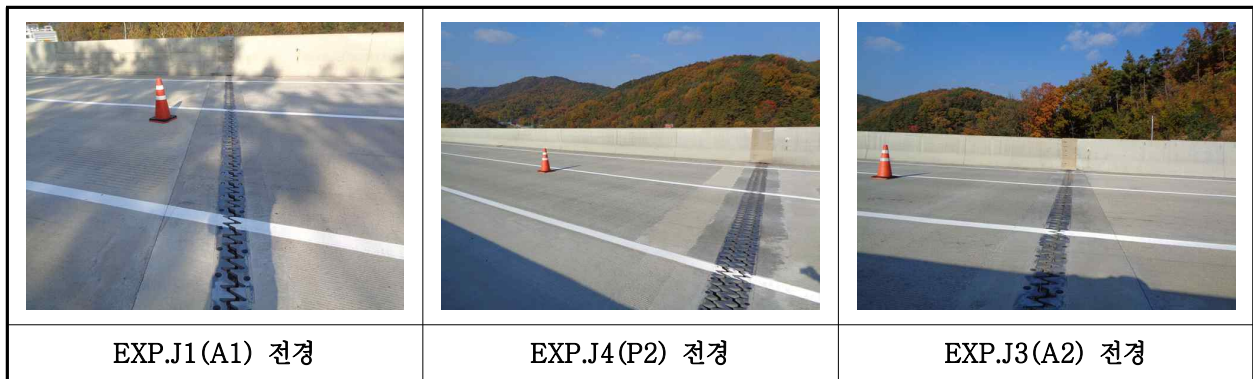
【사진 12.3.39】 신축이음장치 전경
