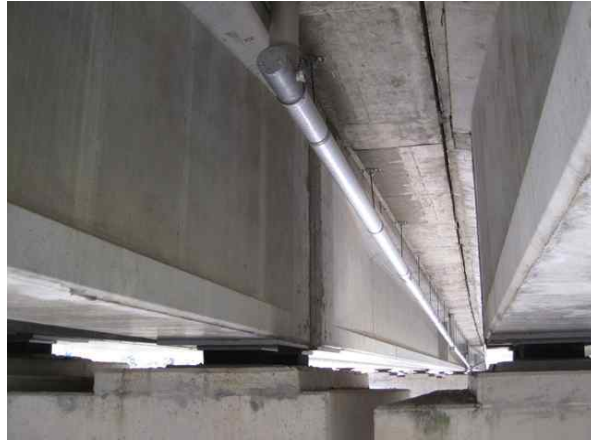
배수시설 상태 양호
