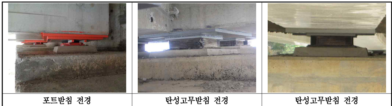
【사진 12.3.35】 교량반침 전경
