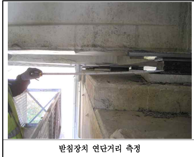
【사진 12.3.37】교량받침장치 연단거리측정
