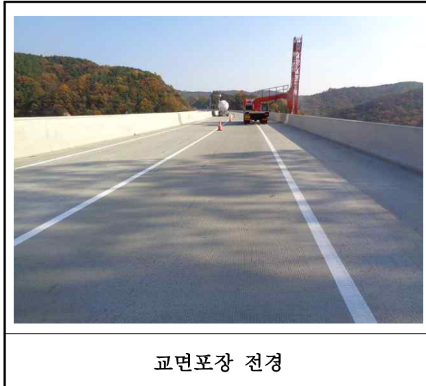
【사진 12.3.42】 교면포장 전경
